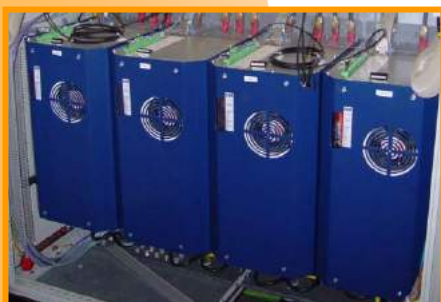
Als Mittelfrequenz-Inverter mit dem entsprechenden Mittelfrequenz-Trafo.
